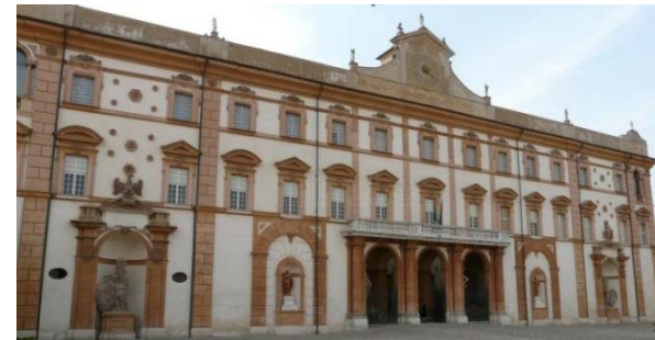
Irregolarità da numero variabile di aperture per piano
