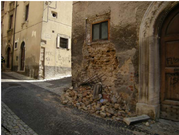
Muratura di pietrame
