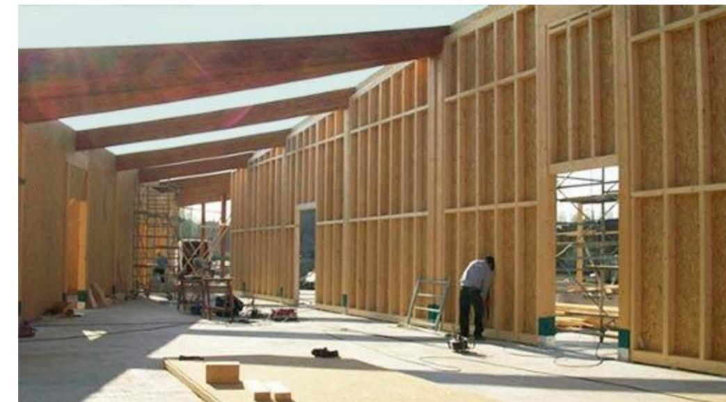
Il sistema xlam è composto da pannelli di tavole di legno incollati posti a strati incrociati, si possono raggiungere differenti spessori, per classiche costruzioni si hanno pareti 80/120 e solaio 160/220. Questo sistema costruttivo consente la realizzazione di solette, tetti e pareti per ogni tipologia di edificio, dalle singole abitazioni fino ad edifici a più piani.
