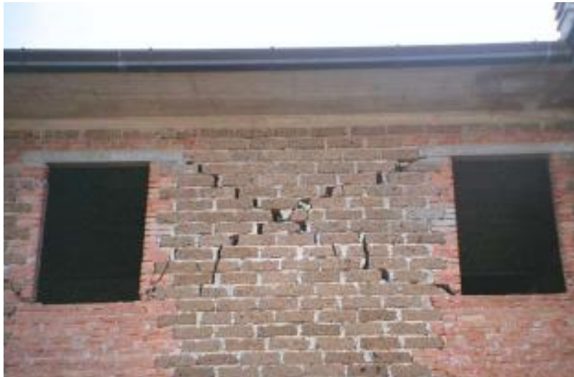
Rottura a taglio diagonale
