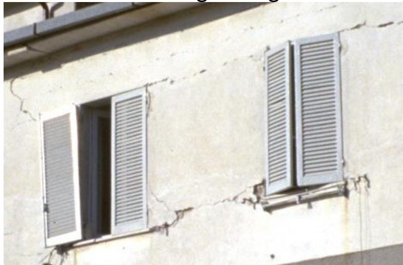
Rottura a pressoflessione
