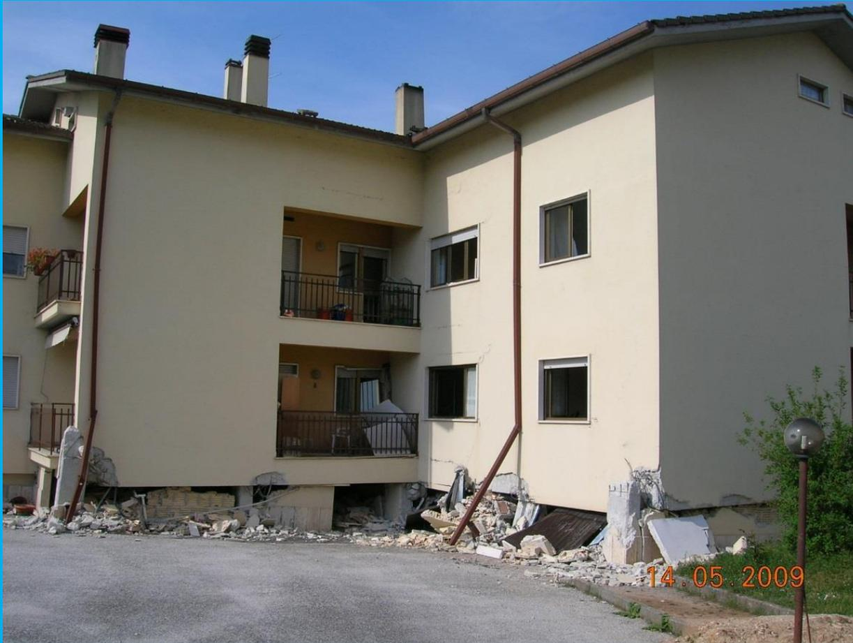
**Terremoto dell'Aquila 2009** - Irregolarità in Pianta ed Elevazione. Distribuzione masse e rigidezze non uniforme.
